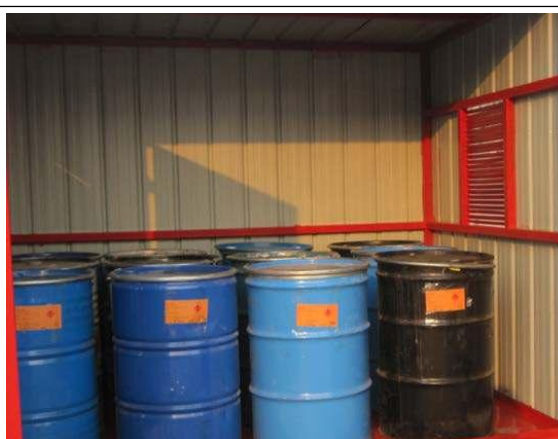
危废暂存间内部
