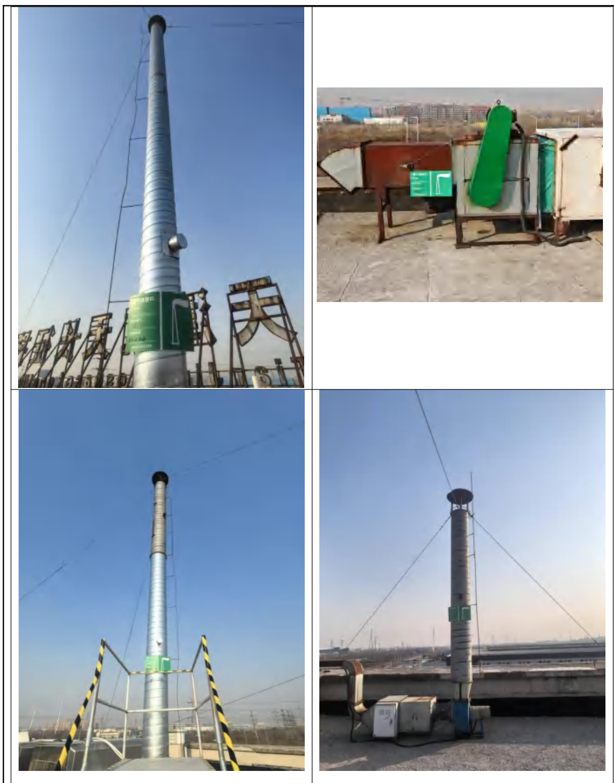
图 14 废气排气筒及废气排口标识
