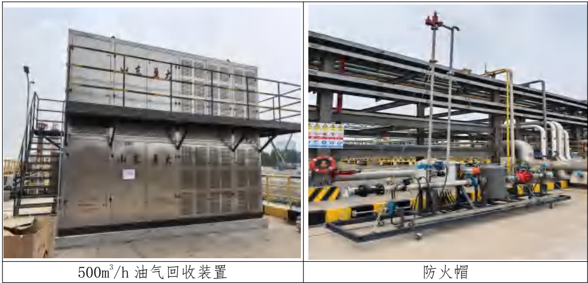
图 3-3 500m³/h 油气回收装置图
