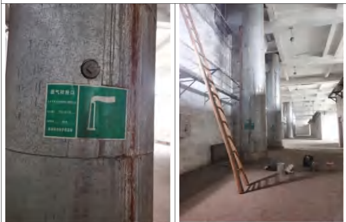
排气筒P 138 及标识牌
