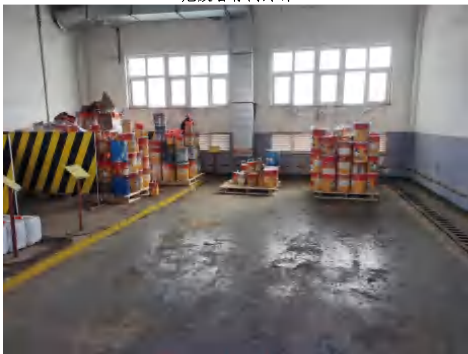
危废暂存间内部
