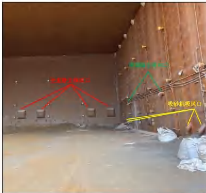
图 3.5-2 喷砂车间半侧排风口设置情况
